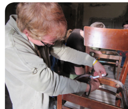
Vanade toolide renoveerimine Esnas
