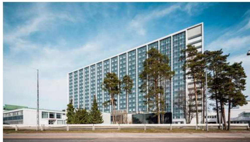
Helsinki Ülikooli Haigla Meilahtis, 49 soojuspuuraku (250m), soojuspumpade võimsus kokku 1,5MW
