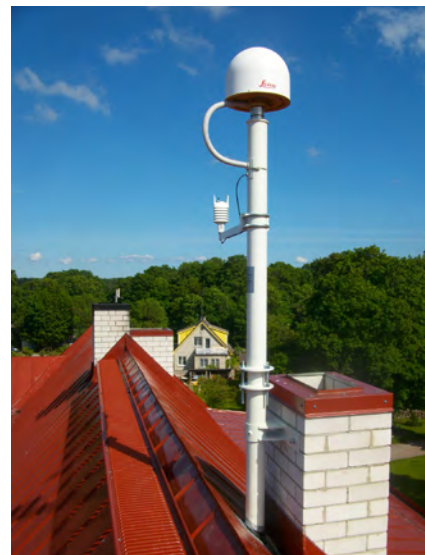
■ Новые базовые станции в Мустьяла и Верги
