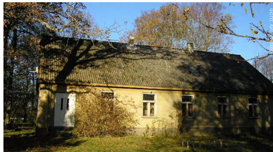
■ Станция воздушного мониторинга в Тахкузе
